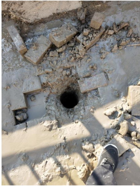
相片 6.5-8 井管制作现场
