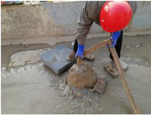
相片 6.5-10 换浆高压注水洗井
